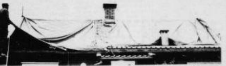
1300 kroner skulle takarbeiderne ha for det nye taket i Breiskallen, men da regnet kom måtte det legges presenning over det hele.
